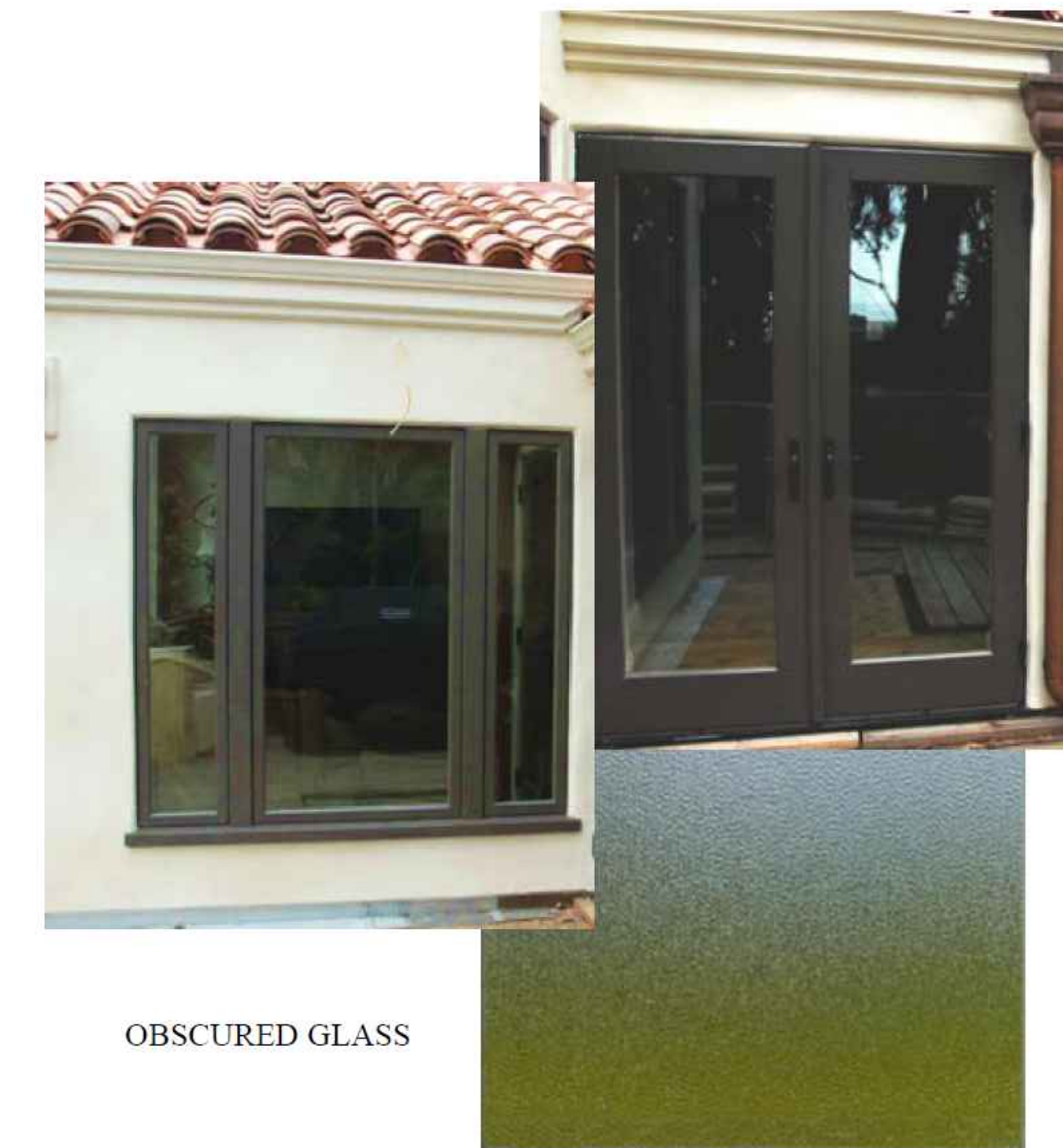
B - METAL CLAD EXTERIOR DOORS & WINDOWS -TYP.
